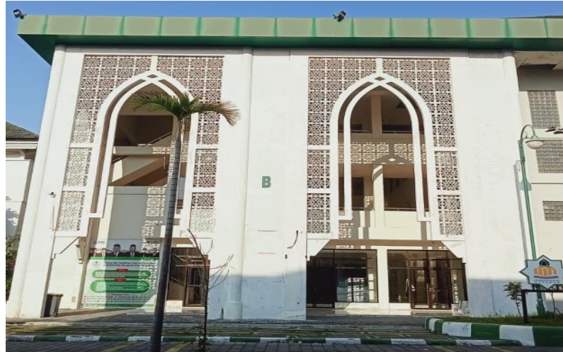
Gambar .1 Bagian depan gedung B FTK UIN Mataram
